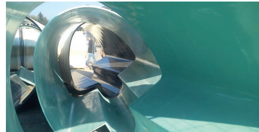
Panele GRP wykorzystane do renowacji
