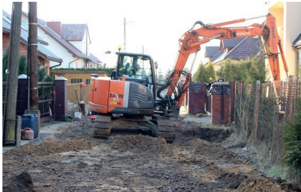
Prace ul. Malinowa
