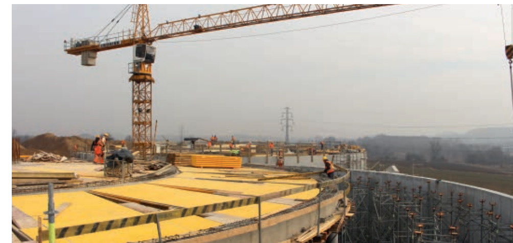
Budowa zbiorników wodociągowych Górka Narodowa wschód
