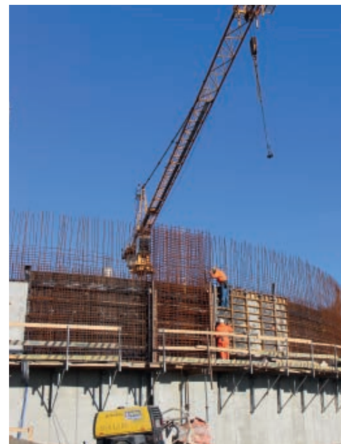
Zbrojenie zbiornika nr 1
