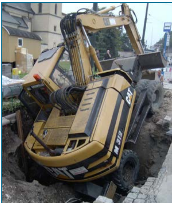
Fot. 2 ul. Kościuszki (awaria rurociągu magistralnego)
