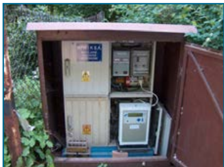
Rysunek 2. Przykładowa stacja ochrony katodowej
