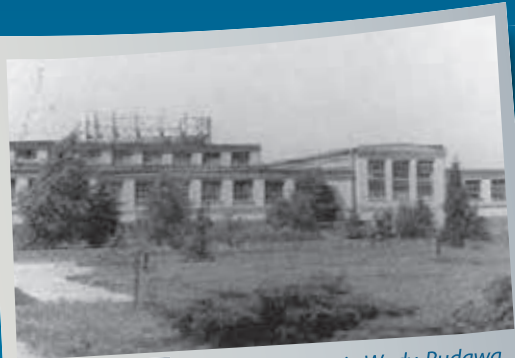
Zakład Uzdatniania Wody Rudawa, budynek filtrów pospiesznych po rozbudowie
