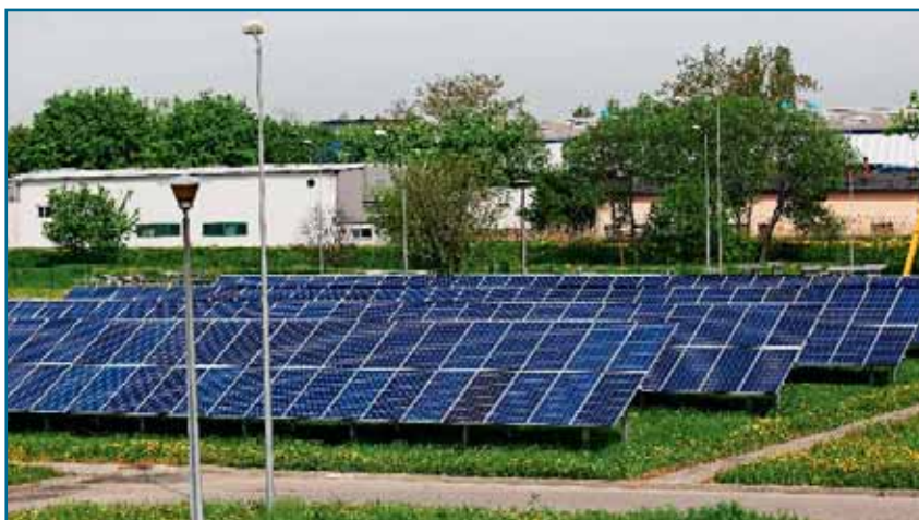
○ Fot 2. Widok farmy fotowoltaicznej na tle obiektów oczyszczalni.
