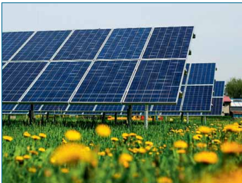
Fot 1. Ogniwa fotowoltaiczne zainstalowane na terenie Oczyszczalni Płaszów
