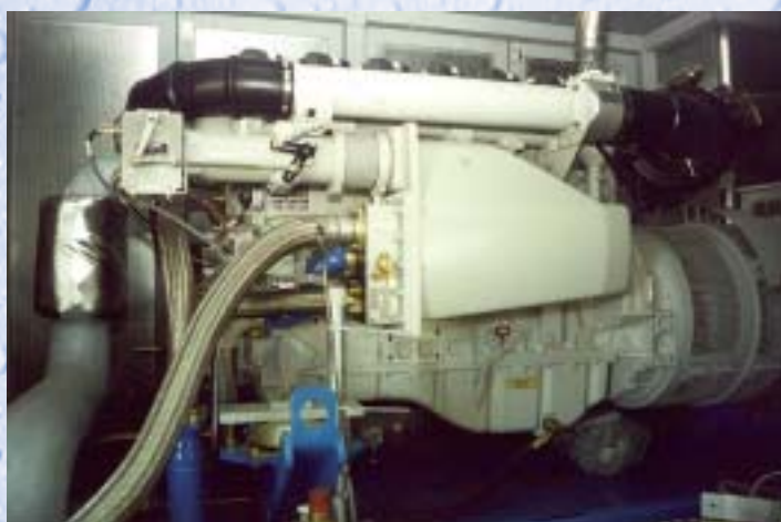
Generator prądu zasilany biogazem
