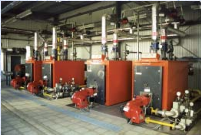
Kotłownia wykorzystująca biogaz i ogrzewająca obiekty oczyszczalni
