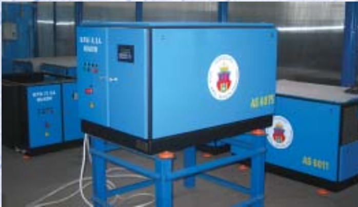
Agregat sprężarkowy w Warsztacie Mechanicznym
