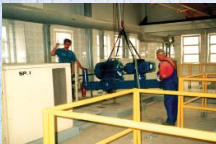
Agregat dmuchawy po remoncie w Warsztacie Mechanicznym Zakładu Utrzymania Ruchu
