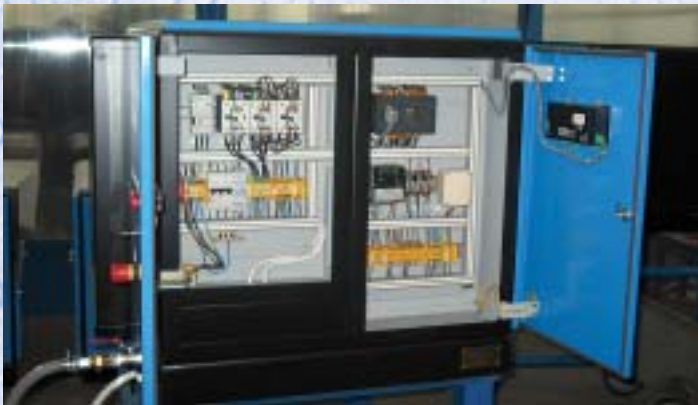
Wnętrze szafki sterowniczej
