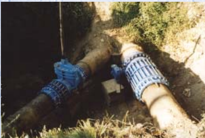
Planowe naprawy bieżące - wymiana armatury w ważnym węźle rurociągów lewarowych ZUW Bielany
