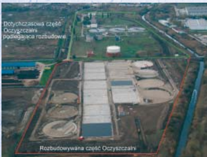
Oczyszczalnia „Płaszów” (z lotu ptaka)
