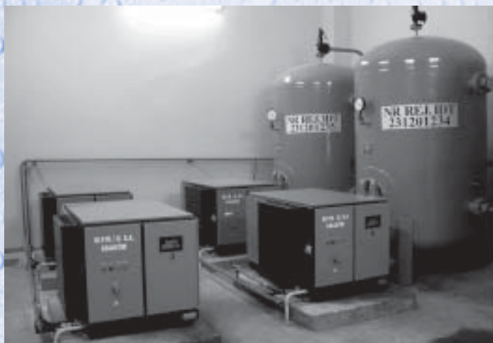
Sprężarkownia w ZUW „Raba”
